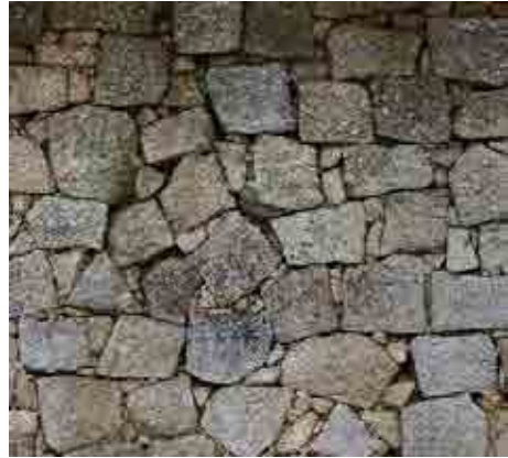
H085 割石（打込み接ぎ）＋布積み
