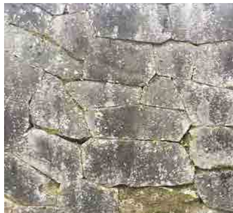
切込み接ぎの例（他城郭での例）
