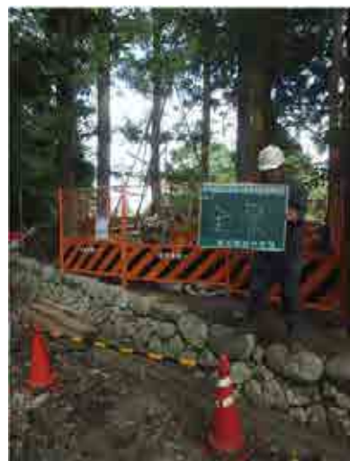
機械ボーリング実施状況
