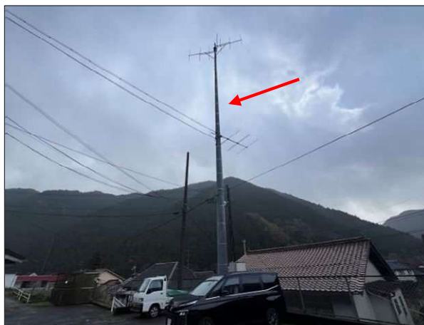
パンザマスト①（旧湯来町役場南側） 旧湯来町同報系のアンテナ柱の撤去
